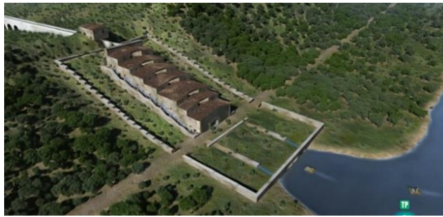
Edificio harinero de Arlés
